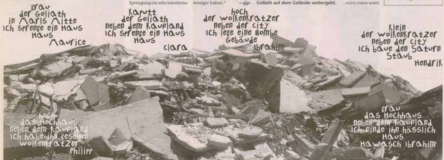
Nur noch über 18 000 Tonnen Schutt ist vom Goliath übergeblieben. Er wird auf dem Gelände zerkleinert und dient als Fundament für den Saturn-Markt.
