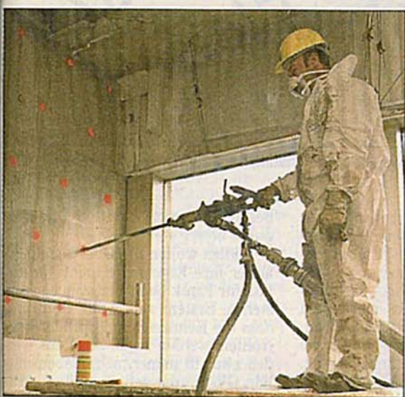
Bohrloch für Bohrloch rückt die Sprengung näher.
